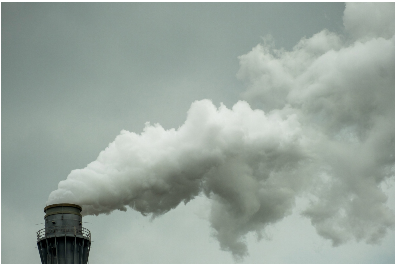
Emissionen eines Blockkraftheizwerks
